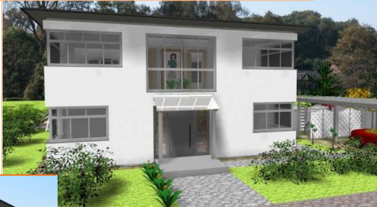
Ansicht der Eingangsseite
