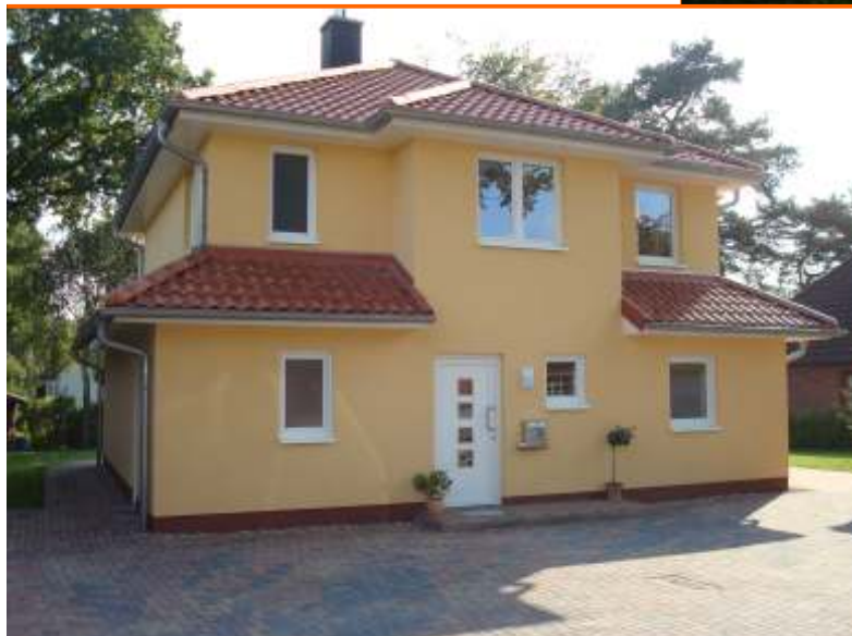
Ansicht der Eingangsseite
